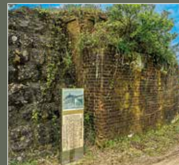
▲物井川橋梁亀崎橋台跡
