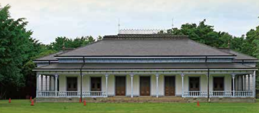
「旧学習院初等科正堂」。1899年に学習院初等科正堂(講堂)として建てられたものが移築公開されています。西洋建築のデザインを取り入れながら、日本の伝統的な木造建築の技術で造られた、この時期の数少ない講堂建築として貴重です。国重要文化財に指定されています。
