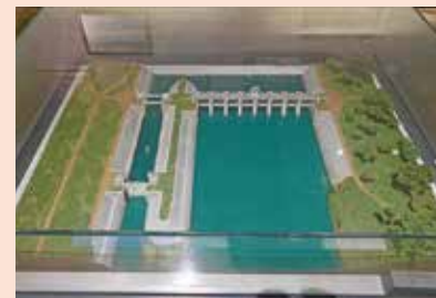
▲関宿水閘門（すいこうもん）模型。川の水量を調節し、船の航行を助けるために設置されました。
