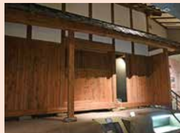
▲水塚カット模型。洪水になった時に避難するための小屋で、高い所に作られます。
