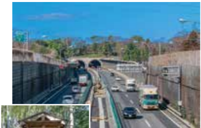
今回の散歩コースでは2度京葉道路の上を渡ります。特に荒屋敷貝塚の下を走るトンネル出口の場所は、公園の端から見渡すことができます。荒屋敷貝塚から貝塚交差点に向かう途中には「山王神社」の小さな祠があります。
