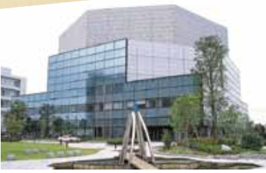
地域熱を供給する エネルギーセンター
