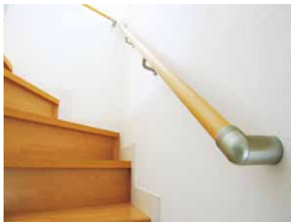
階段の手すりの例
