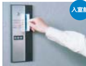
入室チェック 専用カードにより、入室チェックを行います。
