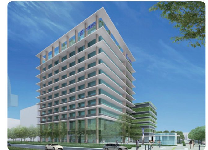
平成27年2月竣工予定
