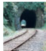
板谷トンネル
