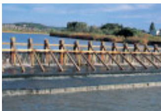
堰の幅は約60m、親柱の高さは平均で約2.9m
