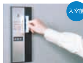
入室チェック 専用カードにより、入室チェックを行います。
